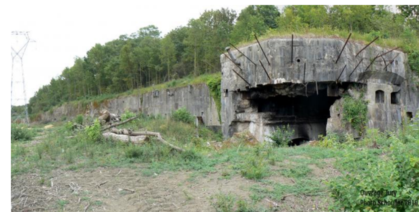
Photographie 39 : Photographie d'un ouvrage militaire
