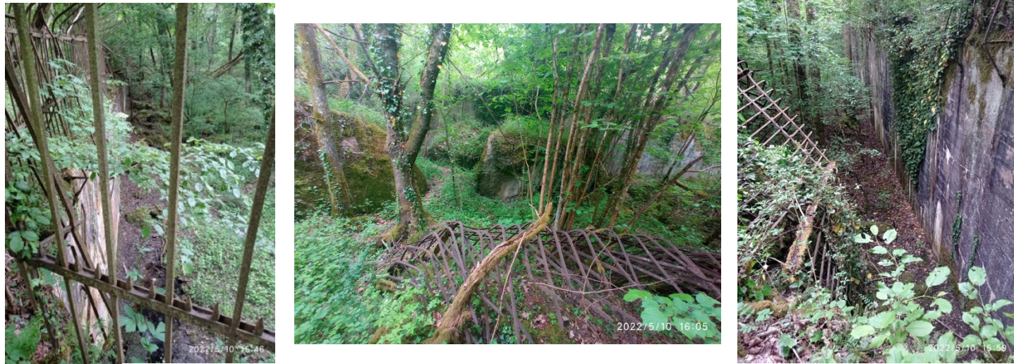
Photographie 13: Fortification de l'ouvrage de Mercy encore bien présente
