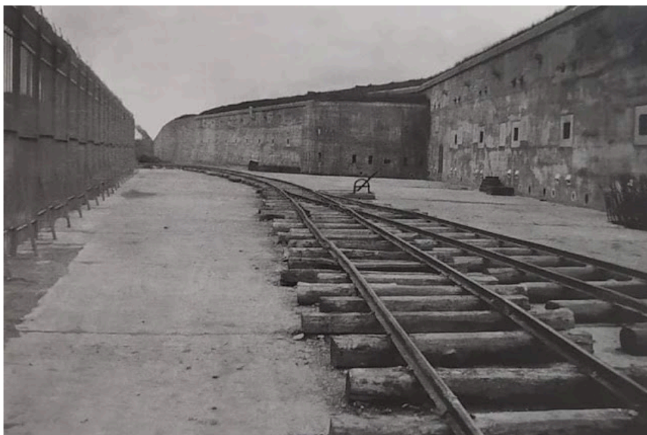
Photographie 1: Ouvrage de Mercy (Source : Mairie d'Ars-Laquenexy)
