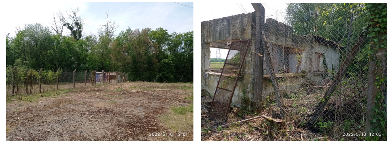
Photographie 12: Parcelle clôturée couverte par un bâtiment en ruine
